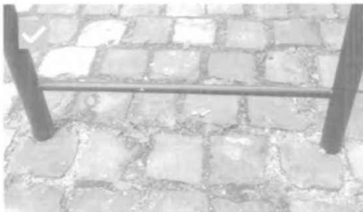
✓ Vhodný príklad povrchová kotvená stojana v kombinácii s dlažbou. Výstava špičky na umiestnenie príchytky
