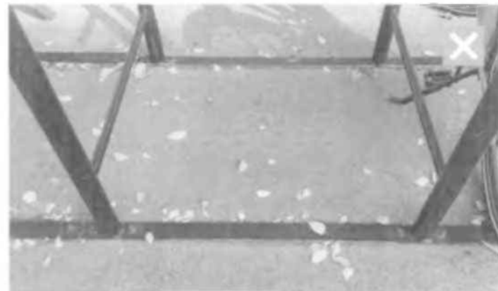
✗ Esteticky menej vhodné povrchové kotvenie cyklostojanov pomocou preradenia jednotlivých stojanov oceľovou pásovnicou. Tento typ je nehodné umiestňovať do historického a kompaktného mesta.
