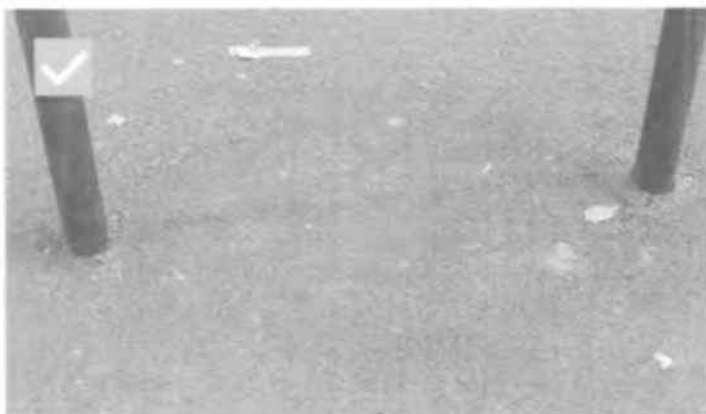
✓ Vhodný príklad povrchová kotvená stojana v kombinácii s výstužením na liatom povrchu
