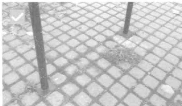
✓ Vhodný príklad povrchová kotvená stojana systém reparačný systém betónovej dlažby
