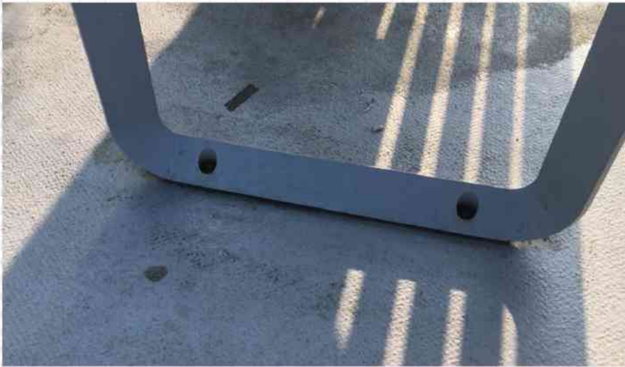
39 Detail kotvenia lavičky na chodníku s liatou úpravou.
