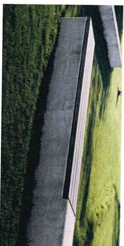
Betónový monolit so zabudovaným dreveným roštom
