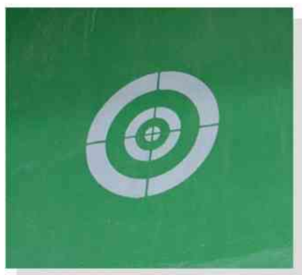
Obr. č.3 - Pozorovaný bod – značka na nosnej konštrukcii
