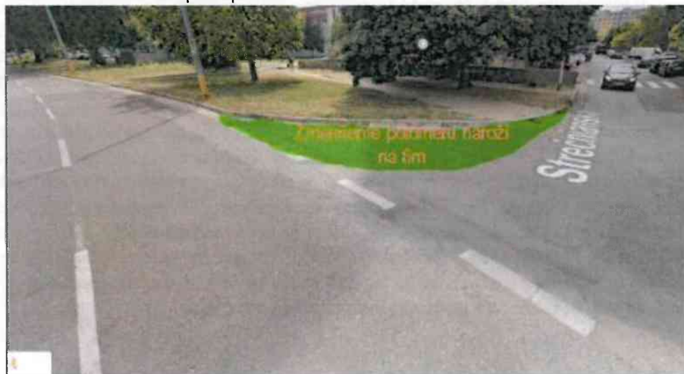
Obrázok 7. Požadovaná úprava polomerov v nároží
