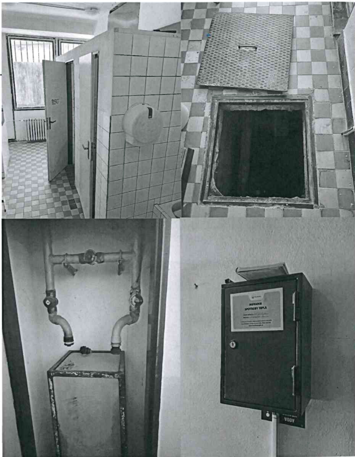
Obr.č.13 – Nefunkčná prípojka plynu
