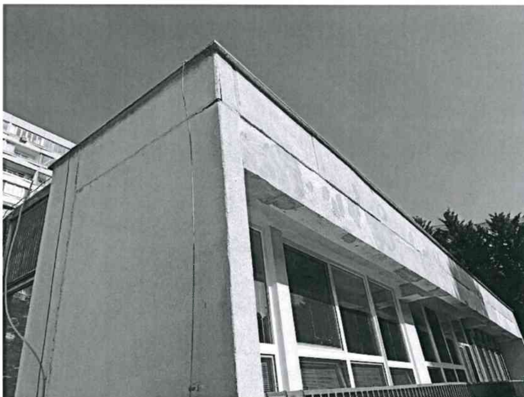
Obr.č.6 – Poškodená atika
