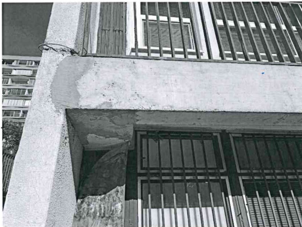
Obr.č.7 – V minulosti sanovaný balkón
