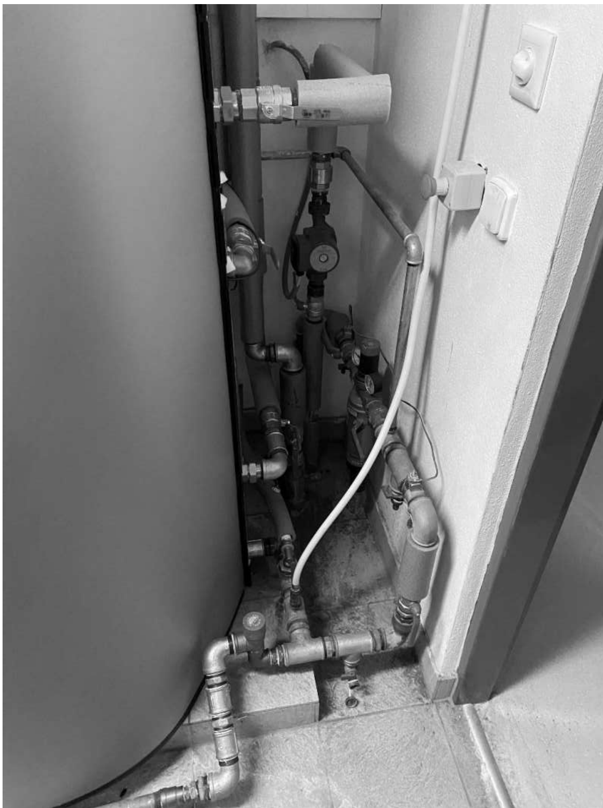
Obrázok 77 438W1 Merací bod pre spotrebu SV pre prípravu TUV v kotolni nová časť.
