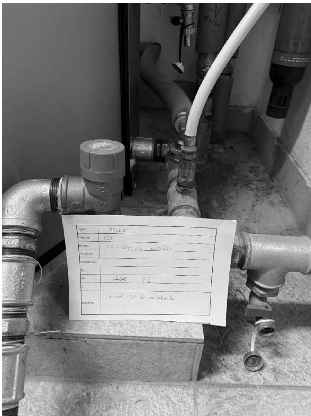
Obrázok 76 438W1 Merací bod pre spotrebu SV pre prípravu TUV v kotolni nová časť.
