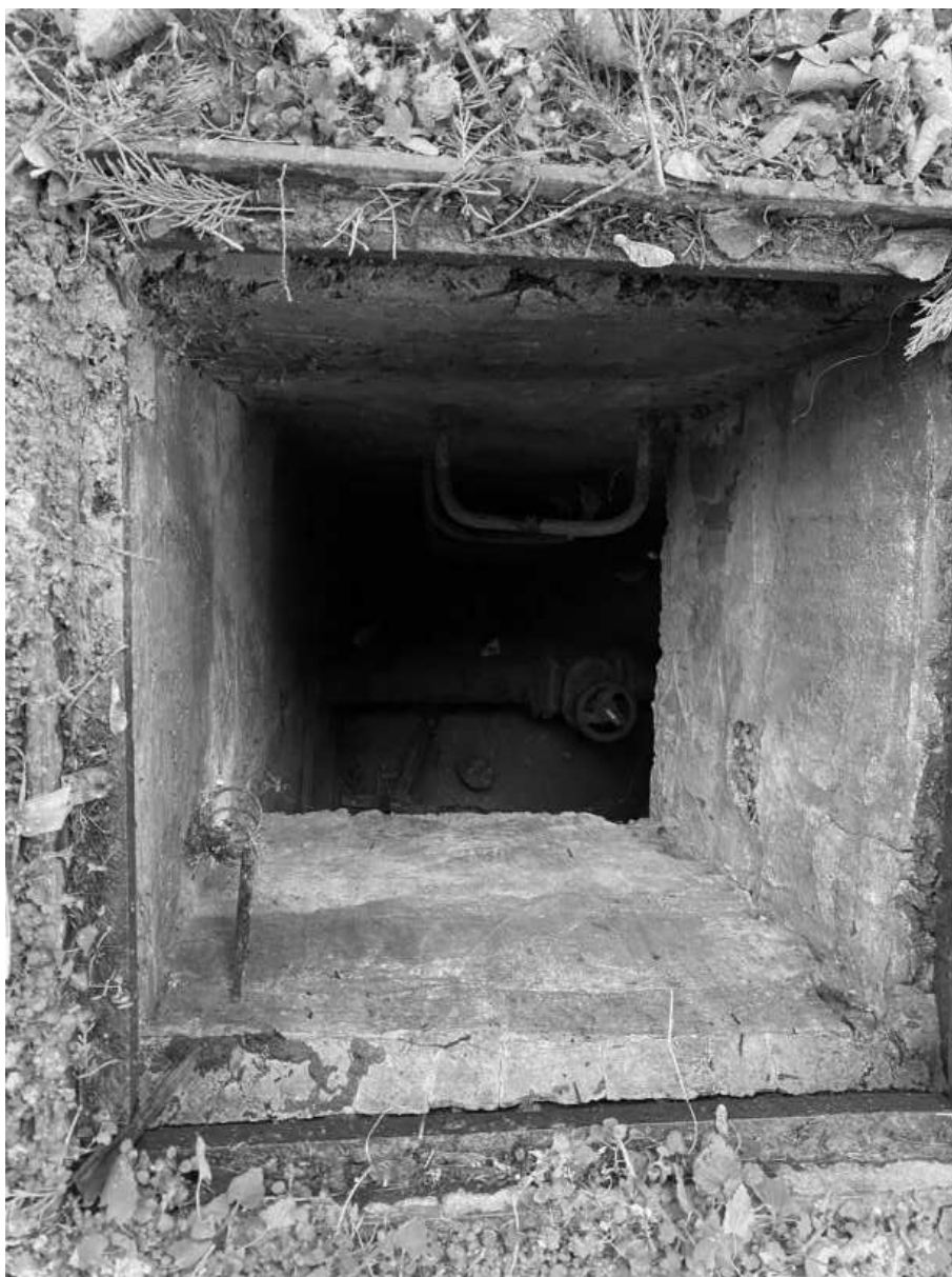
Obrázok 46 vodomerná šachta pre 454W
