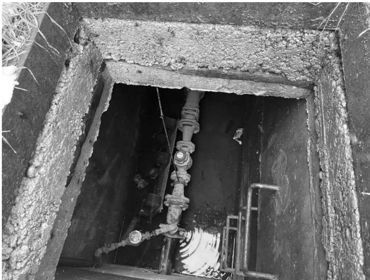
Obrázok 74 hlavný prívod vody do objektu šachta pre 456W1
